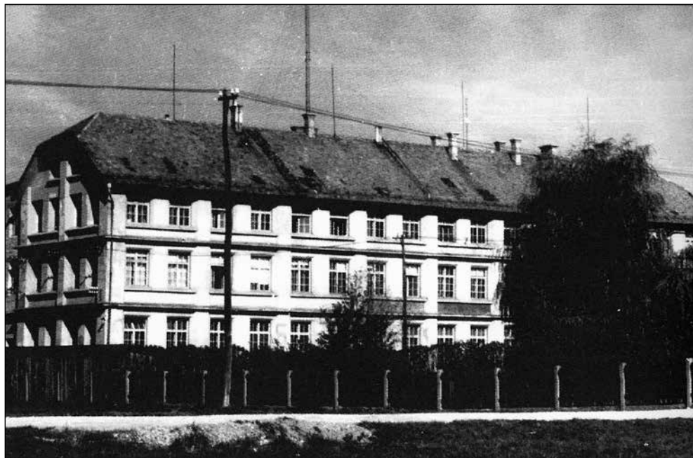
Stavba IEV, bivša Rižarna. Foto: arhiv Boža Bastarja
