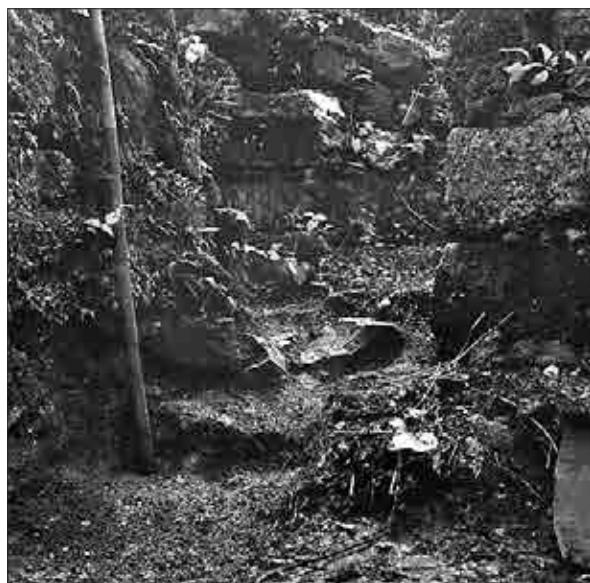
Ostanki zidanega žleba za izpust tekoče litine iz jaška peči leta 1972 (foto: Miloš Magolič, fototeka Gornjesavskega muzeja Jesenice).
