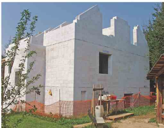
Ytongovi elementi omogočajo čisto in natančno gradnjo. »Rad delam sam, ker sem zelo natančen. Če bi mi gradili drugi, bi bil ves čas poleg kot nadzornik. Pa še plačal bi za to,« se Borut pošali, ponosen na ravne in natančno zgrajene zidove rastoče hiše.
