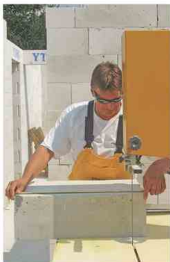
Borut Zlate gradi v Xellinem kombinezonu, zato ga marsikateri obiskovalec, ki se zanima za gradnjo z ytongom, zamenja za profesionalnega zidarja. »Prihajajo in sprašujejo to in ono. Rad jim povem, največkrat pa jim svetujem ogled priročnika za gradnjo z ytongom na dvd-ju, ki je res super stvar. Na njem je vse razloženo. Osebnost sem razdelil med zainteresirane kakih deset teh priročnikov.«
