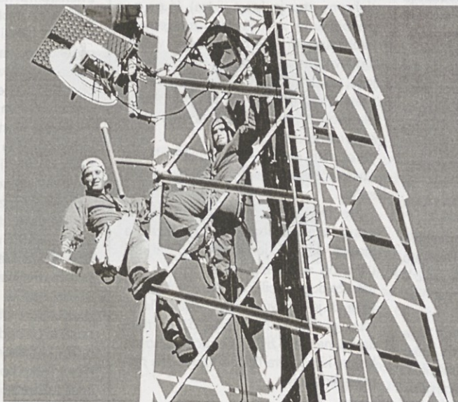
Fotografija postavitve SUPERVOZLA na Travnji gori
