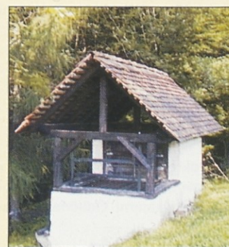
Obnovljena sušilnica sadja na Brankovem pri Velikih Laščah
