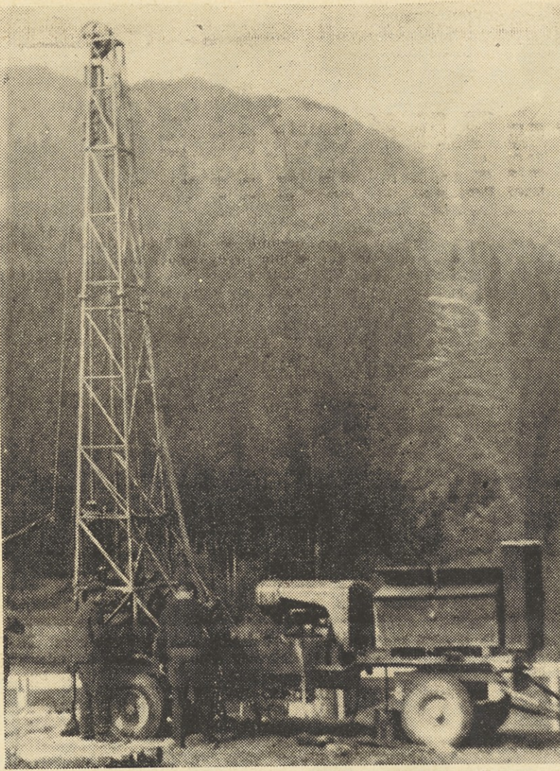
Pripravljamo novo betonarno. V ozadju trasa gondolske žičnice na Mozirsko planino. Na vrhu bo zgrajen tudi velik moderen hotel.
