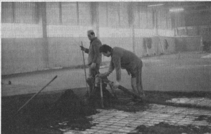
Gradbinci izvajajo dela kljub nizkim temperaturam.
