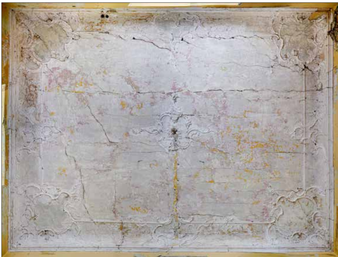
165. Thomas Finsterwalder: štukature v jugozahodni sobi dvorca Novo Celje, 1763 (© ZRC SAZU, UIFS; foto: Andrej Furlan)
