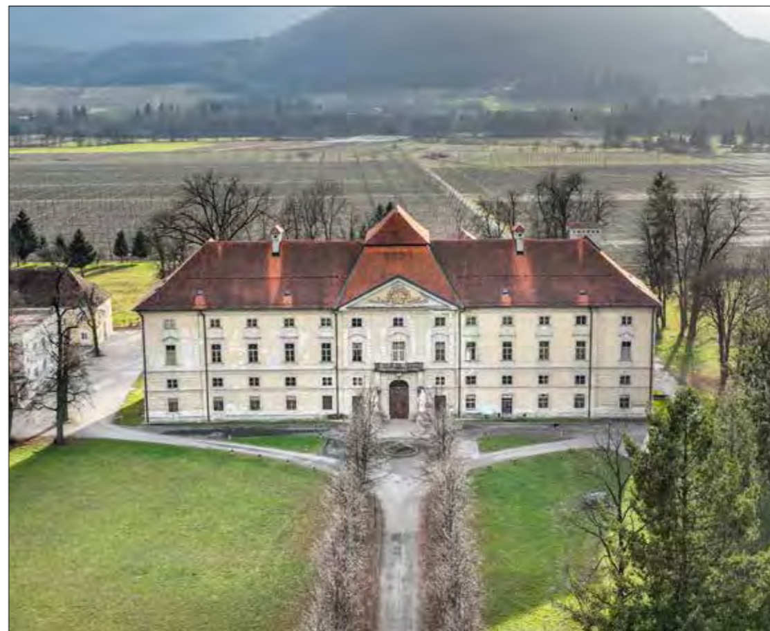
78. Severno pročelje dvorca Novo Celje (© ZRC SAZU, UIFS; foto: Nejc Bernik)
