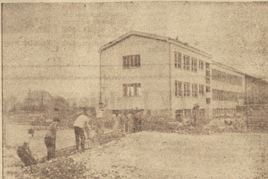
Urejanje kanalizacije za novo poslopje zdravstvenega doma v Ivančni gorici — Kanalizacijo izvaža Komunalno podjetje Ivančna gorica, poslopje pa gradi domače Gradbeno podjetje Grosuplje
