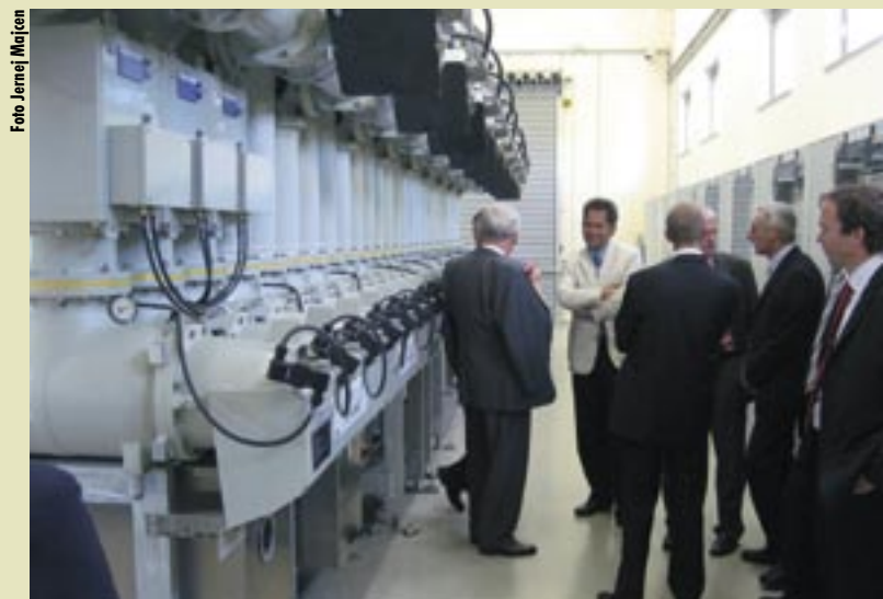
RTP Koper je prvo Elesovo oklopljeno stikališče.
