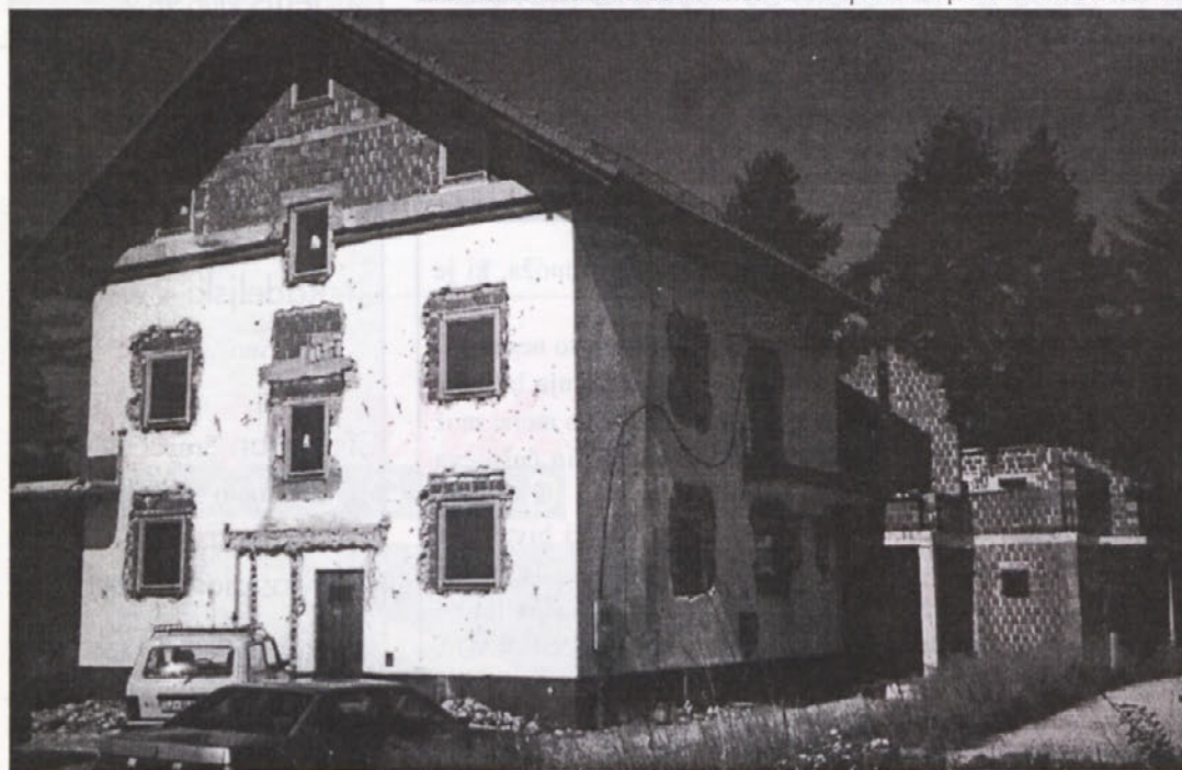
Ali se bo gradnja na Sonjaku sploh še nadaljevala; če ne, bo to velikanska škoda, ki smo jo in jo bomo plačali davkoplačevalci
