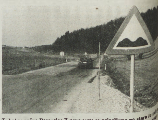
Tukaj se začne Pomurje: Z nove ceste se pripeljemo na stare ceste, no, ki že 18 let ni bila obnovljena; eden od razpoznavnih znakov ceste M 10 — 1 so tudi »kamela«.
