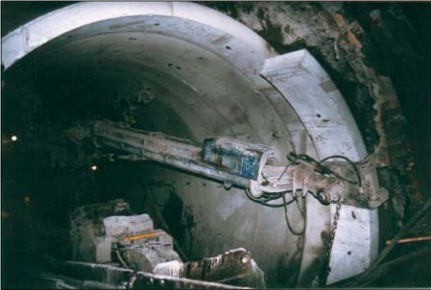
Slika 2. Podgradnja z betonskimi paneli
