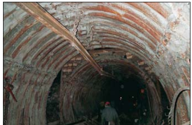
Slika 4. Klasična podgradnja z izolacijsko oblogo
