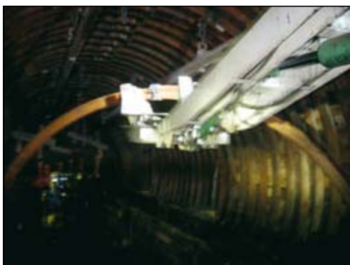
Slika 9. Transport in vgradnja ločnega podporja
