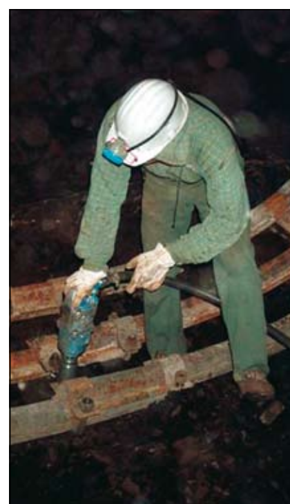
Slika 11. Vgradnja spodnjega dela ločnega podporja in zaključitev profila
