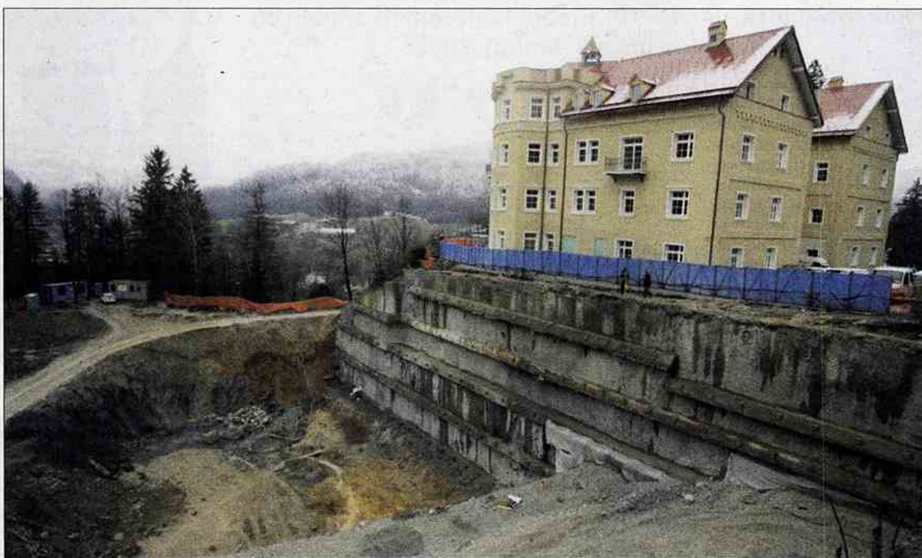
Obnova Sofijinega dvora je zaključena, novogradnja pa se šele začne. V 22 metrov globoki jami bo zrasel sodoben objekt, ki bo Sofijin dvor povezoval z Zdraviliškim domom.
