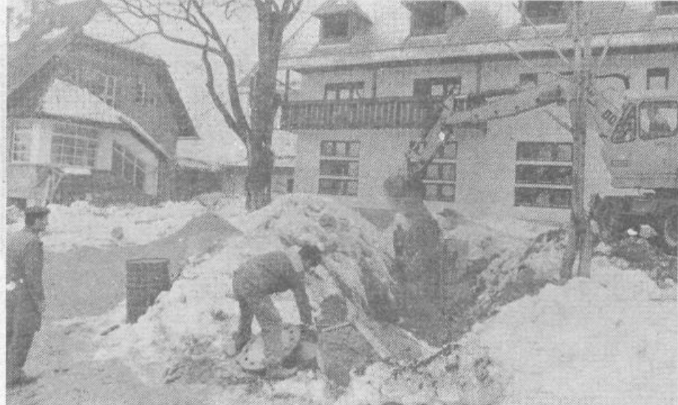
Gradnja na Rakitni se bliža koncu
