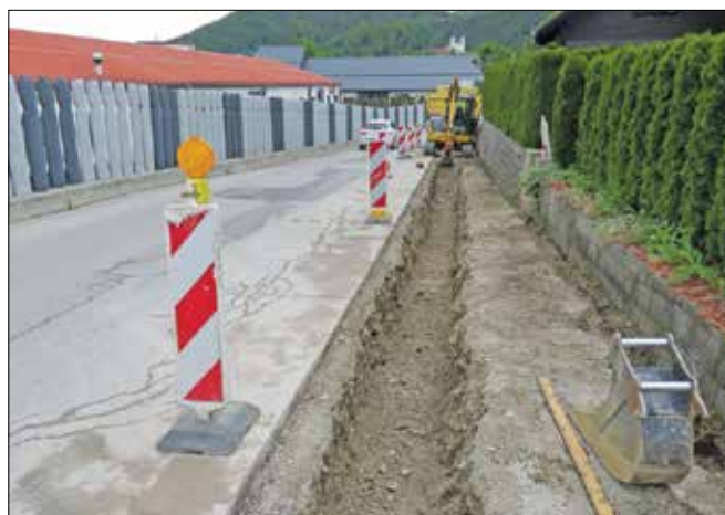
V teh dneh poteka druga faza izgradnje pločnika na območju Lesarske ceste in ulice Pod Slatino ter križišča z Dobletinsko ulico.
