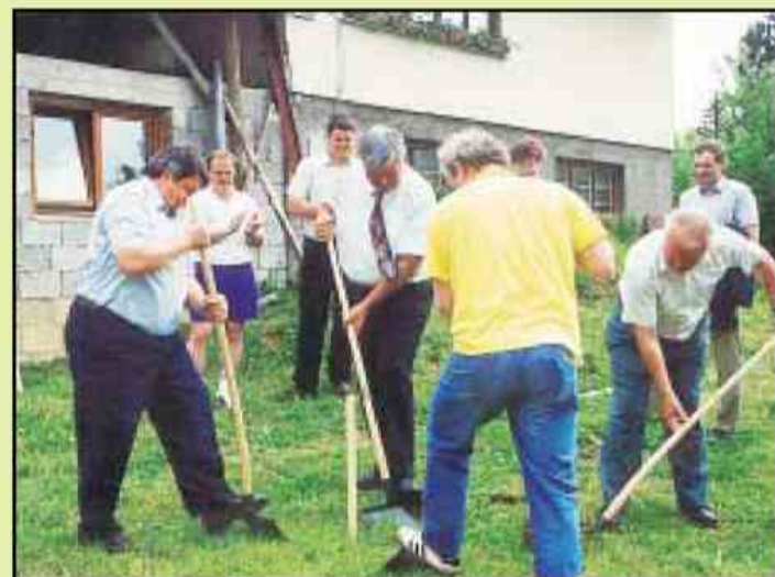
Predstavniki mestne občine Velenje in krajevne skupnosti Konovo so simbolično začeli graditi kanalizacijo v Šembricu
