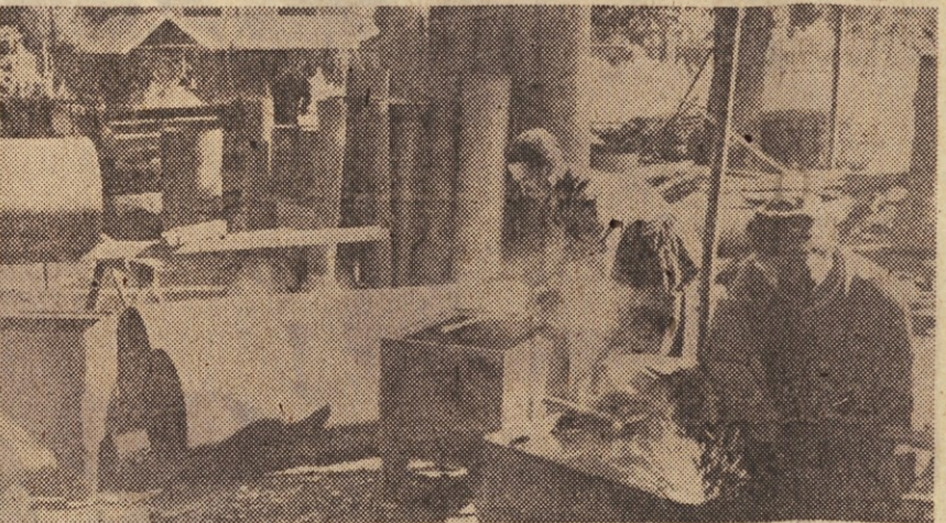
Na dvorišču montažnega podjetja ELEKTROKOVINAR Ptuj — varjenje posod za galvanizacijo
