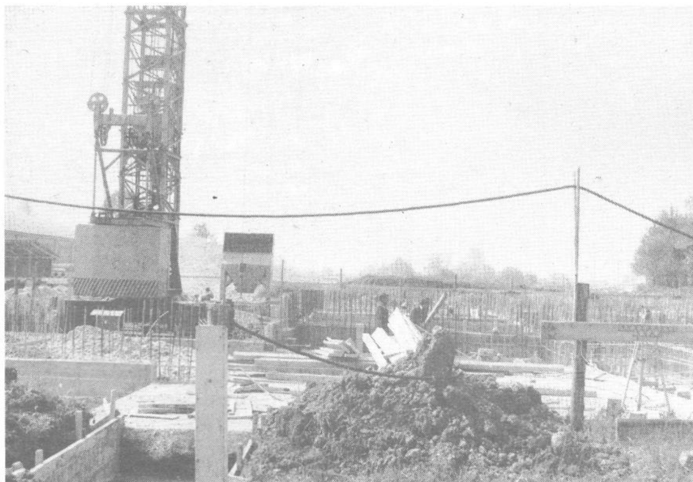
Gradnja napreduje! Posnetek je naš fotoreporter Lado Čuk pred dnevi napravil na gradbišču nove Postaje milice Vič.
