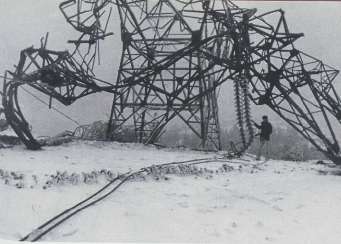
Popolnoma uničim visokonapetostni daljnovodni steber in več kot deset centimetrov debel žled na električnem vodniku (Brkini, 1980)
