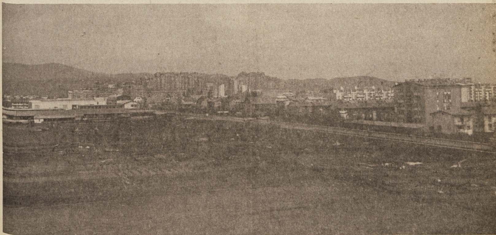
Pogled iz okna DP Emba na lep prazen prostor ob Slovenčevi cesti, kjer bodo nekega dne začeli kopati temelje za prepotrebna skladišča in druge poslovne prostore Mercatorjevih organizacij združenega dela
