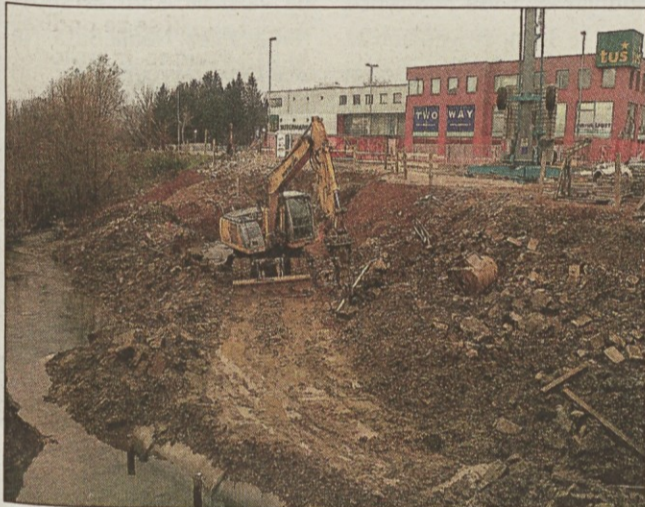
Gradnja krožišča pri Mikozi se nadaljuje.
