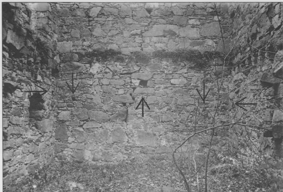
Sl. 13. Pogled na spodnji del južne obodne stene. Levo je niša režastega okenca. Levi in desni puščici kažejo luknje v zidu za shrambno pohištvo; srednja puščica kaže tramovnico vzdolžnega podpornega tramu za stropnike pritličja. Trava raste na zidni polici v prvem nadstropju. Perspektiva na fotografiji je spačena. ♦ View of the bottom part of the southern peripheral wall. To the left the recess of a slot window. The left and right arrows indicate the holes in the wall for the storage furniture; the central arrow indicates the hole for the longitudinal supporting beam of the ground-floor's ceiling joists. Grass grows on the wall shelf in the first floor. The perspective in the photograph is distorted. ♦ Vue de la partie basse du mur de margelle sud. A gauche il y a une niche de fenêtre à fente. Les flèches gauche et droite montrent des trous dans le mur pour les meubles de dépôt; la flèche centrale montre le trou dans le mur pour la poutre longitudinale de support des poutres du plafond du rez-de-chaussée. Au premier étage, les herbes poussent sur l'étagère du mur. La perspective sur la photo est déformée.
