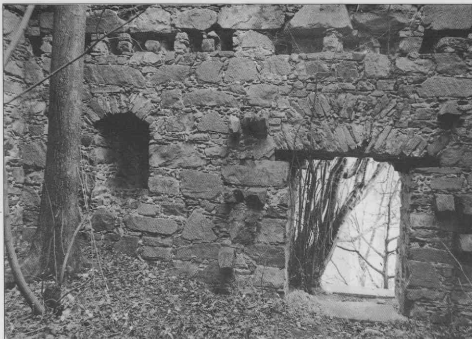
Sl. 9. Pogled na portalno vežo in nišo severnega režastega okenca. Lepo so vidni sidrni kamni za pritlični predelni steni. ♦ View of portal hall and recess of northern slot window. The anchor stones for the ground-floor's dividing walls stand out clearly. ♦ Vue du vestibule du portail et de la niche de la fenêtre à fente nord. On distingue bien les pierres d'encrage des deux cloisons du rez-de-chaussée.
