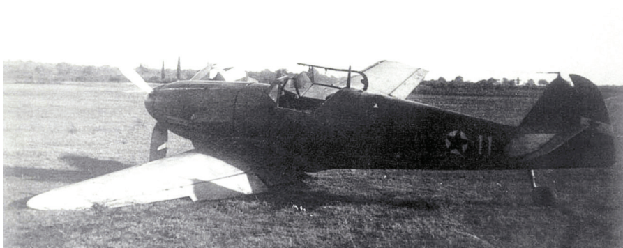
Zasilni pristane podporočnika Albina Pibernika z Bf-109G-10 z evidenčno številko 9611, 28. novembra 1951. Pri vzletu je z letala odpadla leva noga podvozja, pilot pa je uspešno pristal samo z eno. Drugih večjih poškodb na letalu ni bilo. Konice kril so belo obarvane, da so se messerschmitti 83. lovskega letalskega polka razlikovali od messerschmittov 172. lovskega letalskega polka, s katerim so imeli skupno vajo. (Vir: zbirka Marka Malca)
