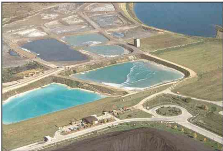
Območje sanacije ugreznin med Velenjskim in Družmirskim jezerom, kjer se odlaga pepel in produkti razžveplanja.
