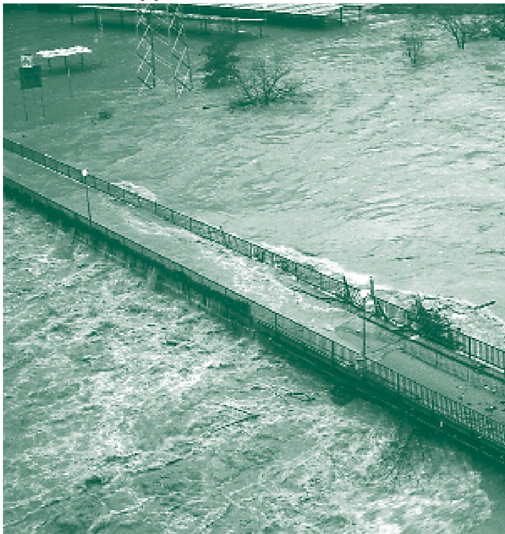
Dovoz do elektrarne ob poplavah leta 1991.
