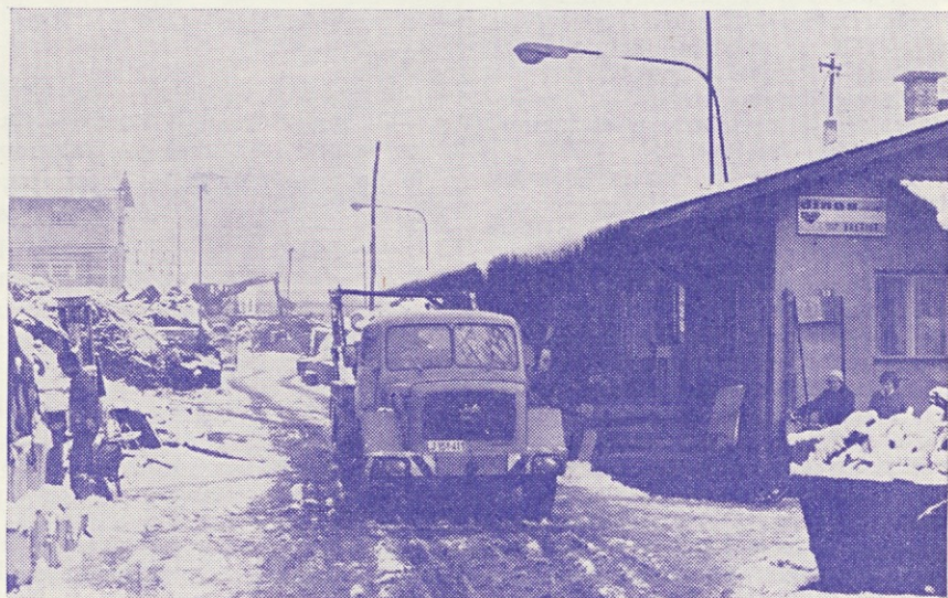
Pogled iz enega na drugi konec skladišča poslovalnice v Brežicah
