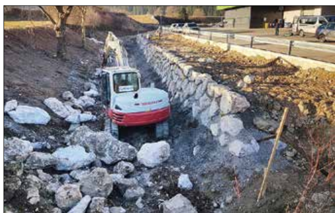
Izvajalci podjetja Nivo eko urejajo vodotok in cesto na območju Industrijsko poslovne cone Loke. (Fotodokumentacija Občine Ljubno)
