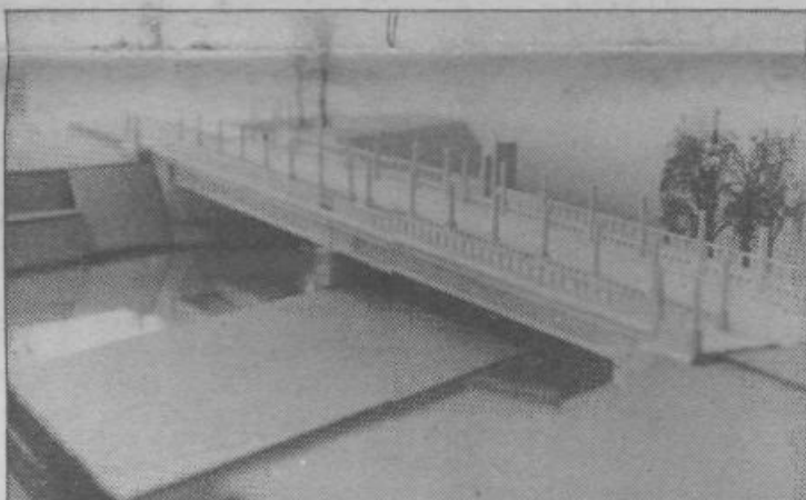
Takšen bo novi fužinski most
