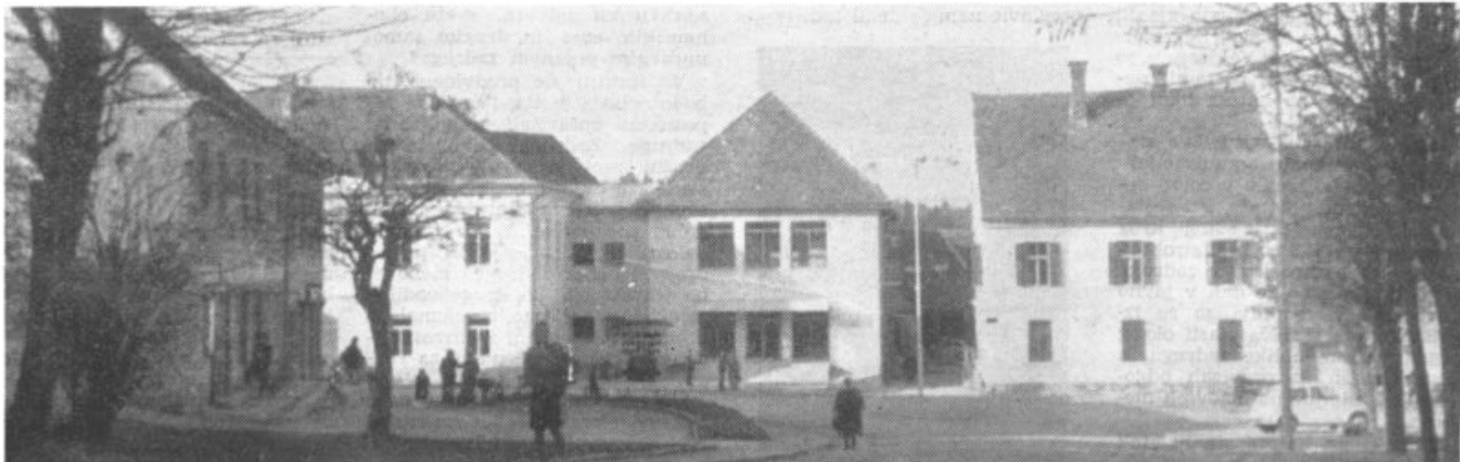
OBNOVLJENI TRG V LENARTU — Pri Lenartu so v počastitev Dneva republike odprli obnovljeno gostišče (na sliki levo) in kulturni dom (na sliki v sredini). Lepo urejenim zgradbam v trgu se je priključila še hiša (na sliki desno), v kateri je mesnica KZ Lenart. Lenart sedaj s tlakovanimi ulicami, moderno cestno razsvetlavo, urejenimi parkirnimi prostori, z novo gostilno in kulturnim domom, sodi med najlepše kraje naše občine.
