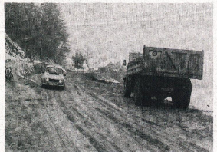
ASFALT SPOMLADI? — Rekonstrukcija ceste Stranska vas pri Dobrovi — občinska meja kljub neugodnim vremenskim razmeram počasi le prehaja v sklepno fazo. Nova trasa (na delu ceste) je pripravljena, na asfalt pa bo najbrž treba počakati do pomladi. (B. V.)
