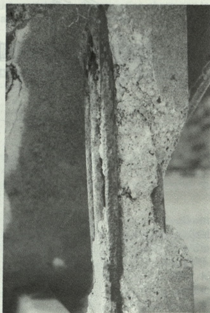
Slika 3, 4: Karakteristične poškodbe vešalk
