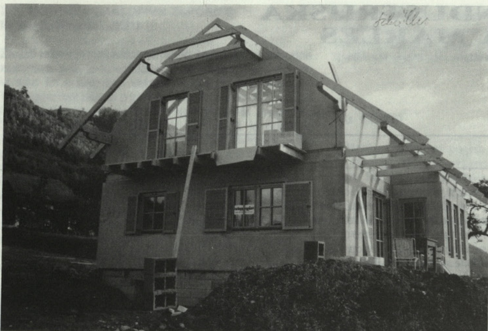
Grobo – z dvigalom montirana hiša
