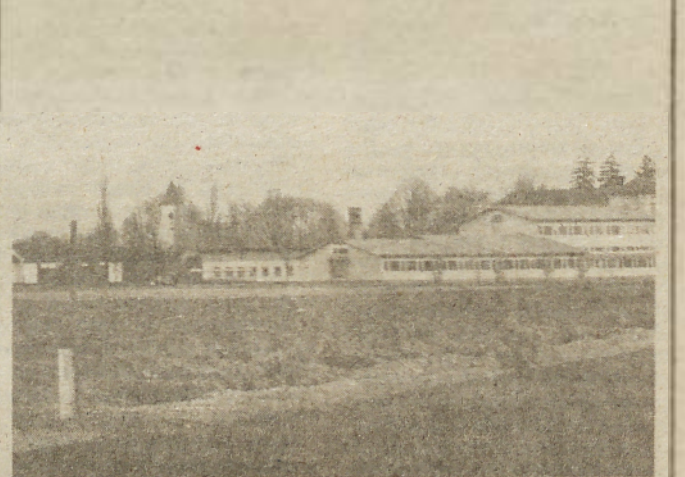
Panoramski posnetek vzgojnega centra: Osnovna šola in Zavod daje občutek pomembnega središča. Veržej to tudi je. Tržani pa sami skrbijo, da se kraj spreminja.
