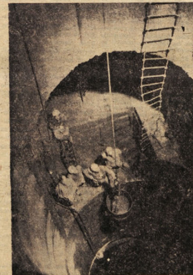
Poglobljanje izvoznega jaška v Rudniku Bor — dela opravlja Oddelek za specialna rudarska dela Rudnika Trbovlje—Hrastnik
