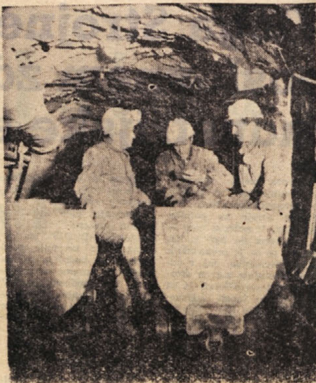
Odvoz hribine na V. horizontu pri poglobljanju jaška v Boru — delo opravlja Oddelek za specialna rudarska dela Rudnika Trbovlje—Hrastnik
