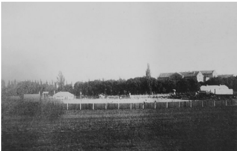
Slika 4: Igrišče SV Rapida na Poljanah. Vir: Arhiv ŽŠD Železničar.
