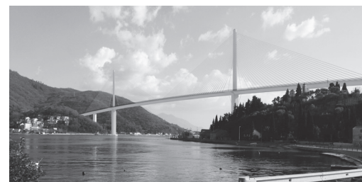
Sl. 13: Most Verige, avtocestni most, Kotorski zaliv, Črna gora. Natečaj, 1. nagrada, v izvedbi. Avtorja natečajne rešitve: Janez Koželj, Marjan Pipenbahr. Dolžina: 1.335 m, največji razpon: 450 m. Konstrukcija: most s poševnimi zategami z dvema pilonoma, prednapeta betonska škatlasta konstrukcija. Tehnologija: prostokonzolna gradnja. Naročnik: Monteput, d. o. o., Podgorica, Črna gora. Vizualizacija: arhiv avtorjev.
