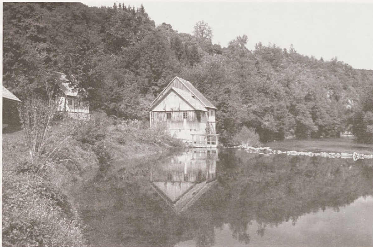
Primer mlina z žago - Žagarjev mlin z žago v Damlju, foto Dušan Štepec, september 2000.
