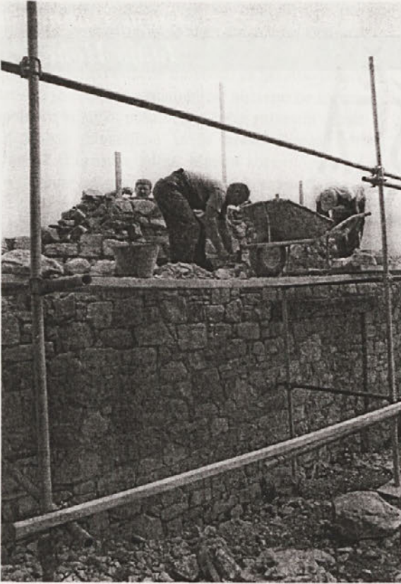
Obnova zahodne fasade
