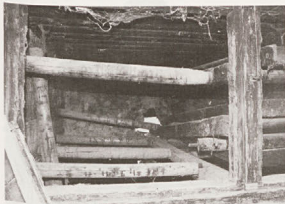
Lovrenc na Pohorju, notranjščina pred obnovo (dere, valji za premeščanje), 1994, dokumentacija ZVNKD Maribor.
