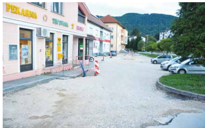
Prostor je že skoraj pripravljen za novo asfaltno prevleko.
