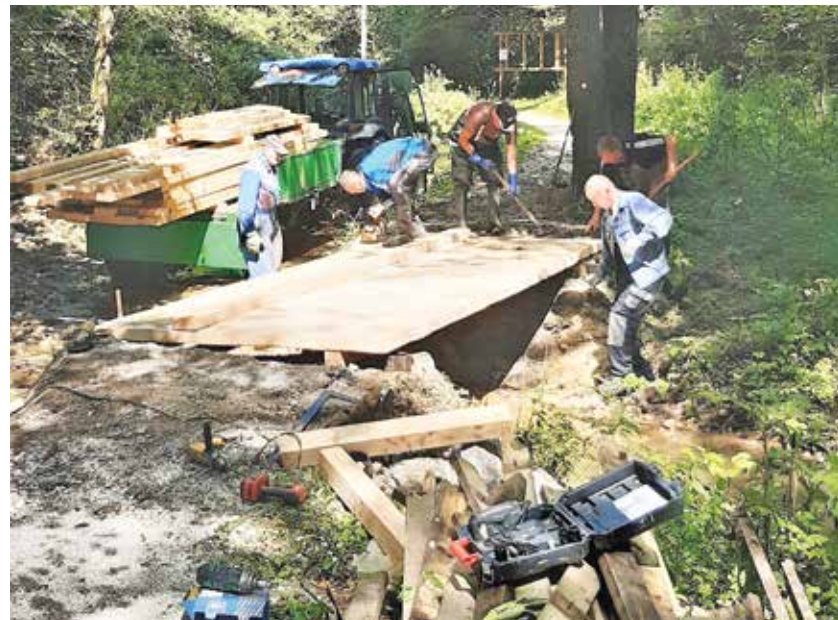
Med delom pri izgradnji prvega mostu preko Peklenšičice v bližini parkirišča za jamo
