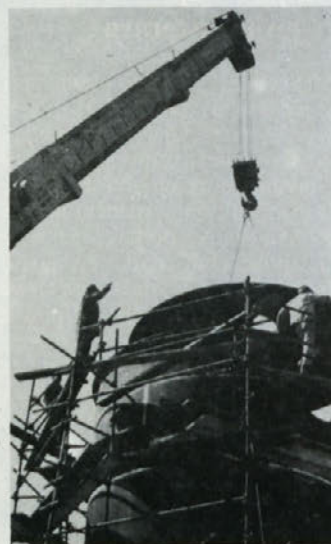
Obnova elektro filtra
