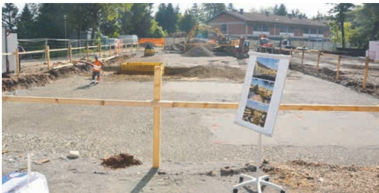
Gradnja nove enote za dementne osebe se je začela.
