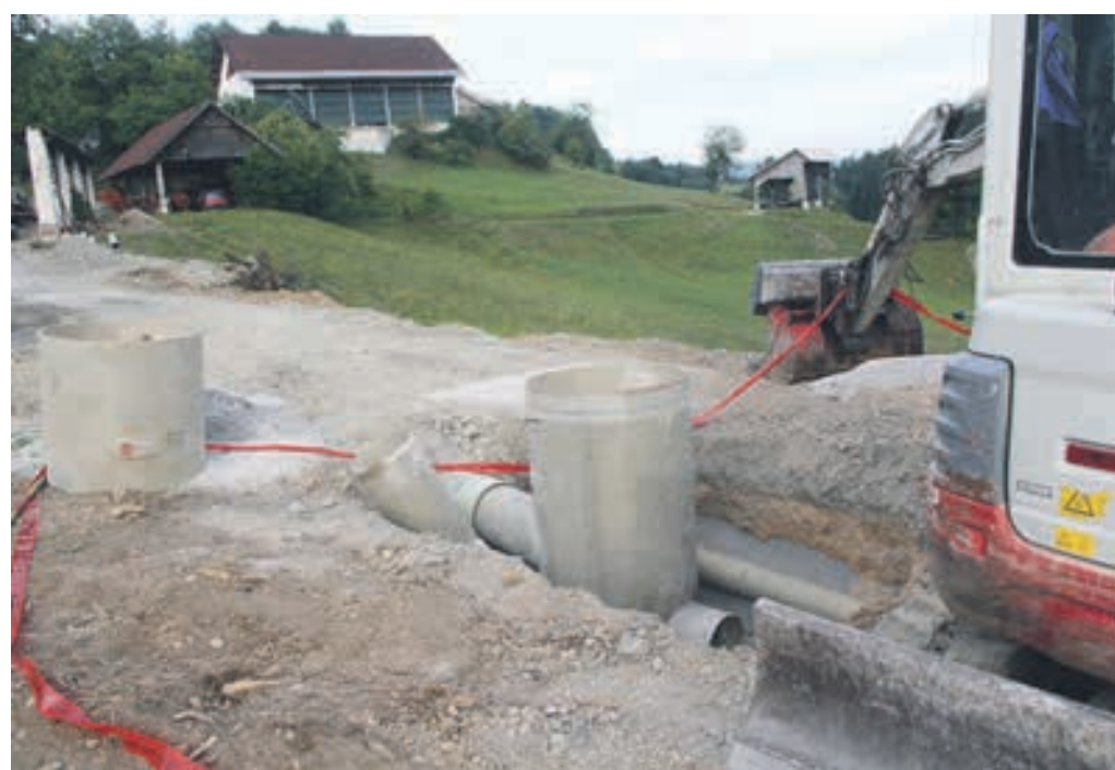
Sočasno z gradnjo kanalizacijskega omrežja poteka tudi gradnja meteorne kanalizacije, polaganje optike, obnova vodovoda in gradnja javne razsvetljave.
