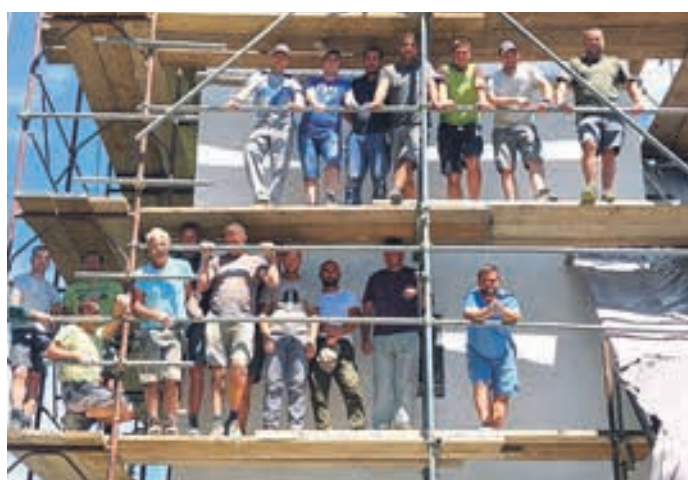
Ena gasilska slika, ki je nastala med obnovo zvonika.
