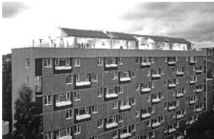
Obnovljena fasada Priory Heights
