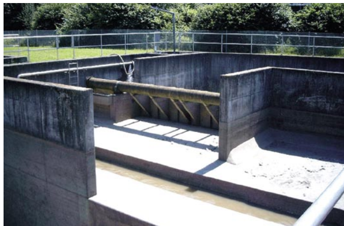
Slika 4 • Pogled iz razbremenilnega bazena (RÜB) na loputo HST-ASK v Aalenu
