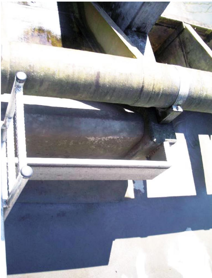
Slika 9 • Pogled na prelivni rob plovcia s potopno steno
