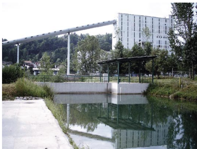
Slika 15 • Pogled na objekt z loputo HST-ASK in na zasilni preliv
