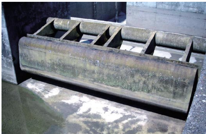
Slika 3 • Pogled s strani vodotoka na loputo HST-ASK v Aalenu
