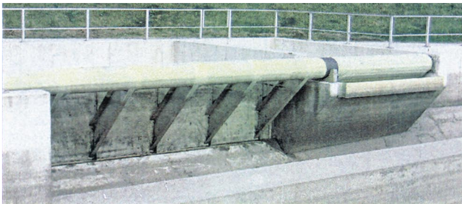
Slika 2 • Pogled s strani dotočnega kanala na loputo HST-ASK (levo) s prelivnim robom za krmiljenje plovca (desno)
