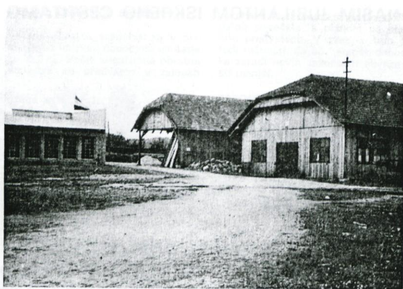
1953 — pogled na staro barakarno in del montaže sedanjega obrata DP
