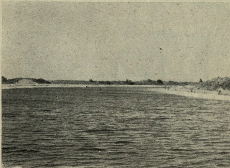
Pogled na glavni dovodni kanal
