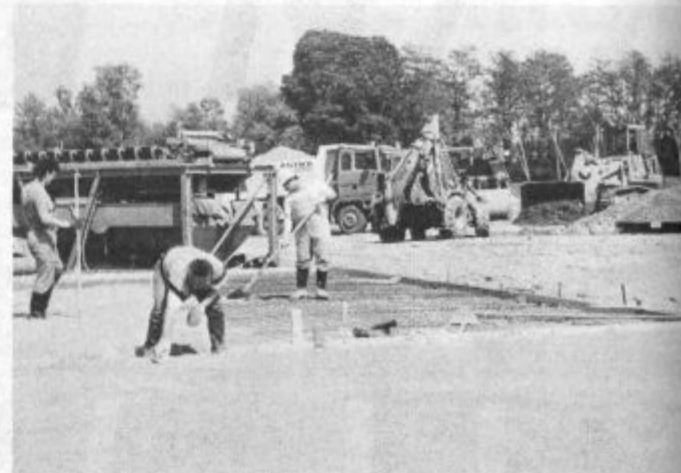
Gradnja začasnega gradbenega naselja v Latkovi vasi.
