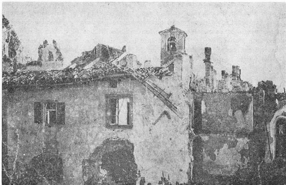
Leta 1915 porušena cerkev na Skalnici (Sveti gori)
