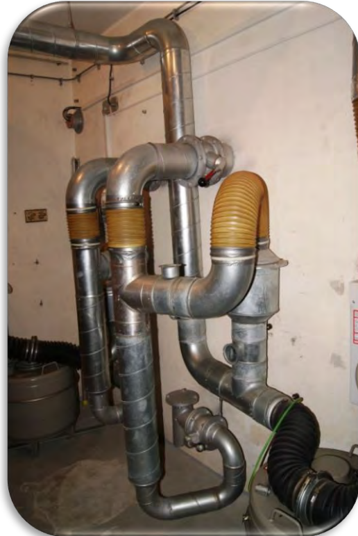
Slika 7 in 8: Leva slika prikazuje filtrirni sistem zračenja, desna pa zračni sistem v zaklonišču na Mojstrski ulici. 26
