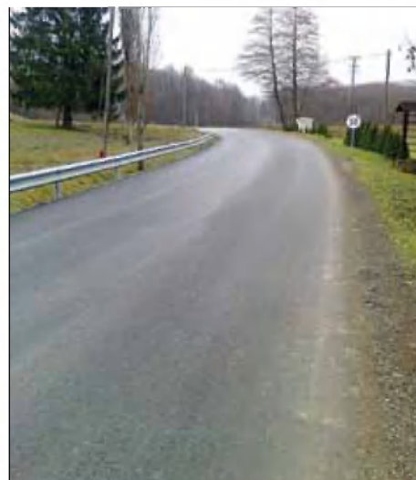
Preplastitev odseka ceste Rašica–Rob (Podlog)
