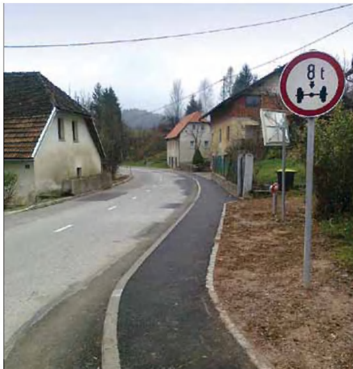
Obnova vodovoda Velike Lašče (Cereja)
