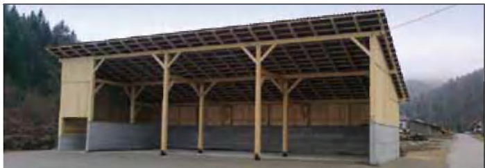
Novo skladišče za zimsko službo
