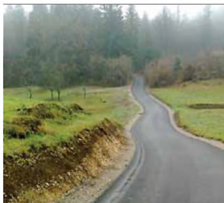
Odsek Gradež–Sloka Gora
