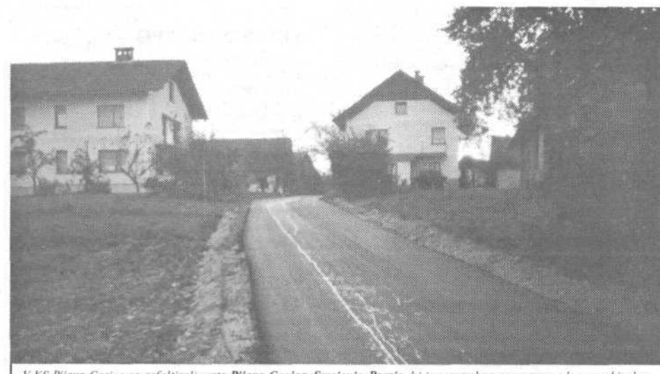
V KS Pijava Gorica so asfaltirali cesto Pijava Gorica-Smerenje-Brezje...
