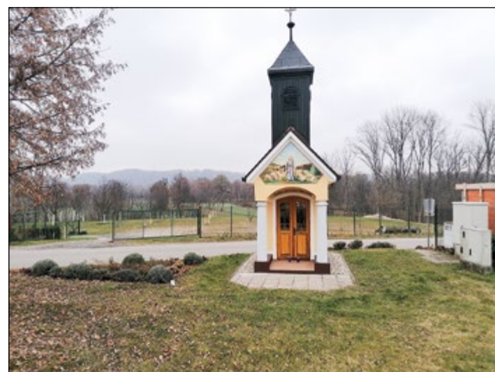
Na kapeli v Hajdošah so končana obnovitvena dela.
