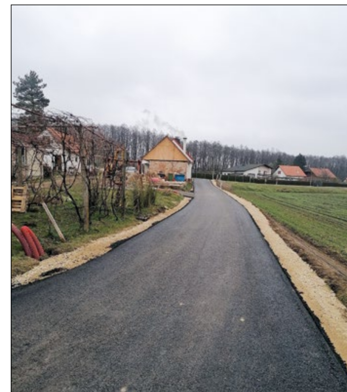
Asfaltiranje ceste na Spodnji Hajdini (odsek Mohorko)
