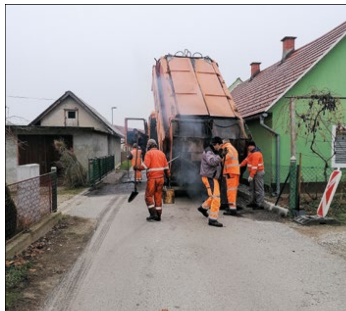
Občina je še pred zimo na nekaterih odsekih cest (na fotografiji odseka v Gerečji vasi in Skorbi) poskrbela za redno vzdrževanje in manjša asfaltna dela.
