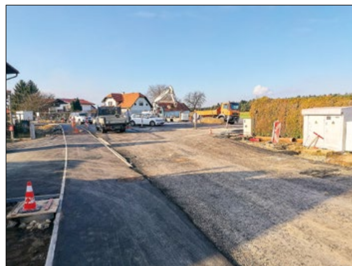
Cestarji končujejo izgradnjo krožišča na Zg. Hajdini, ki že dobiva končno podobo.
