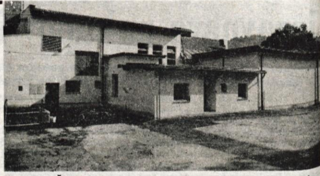
Klavnico v Škofji Loki posodablajo. Ko bodo dela končana, bo izpolnjevala pogoje za pridobitev izvoznega statusa.
